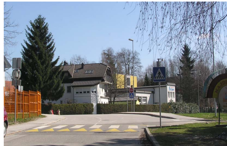
Po izvedbi ukrepa
